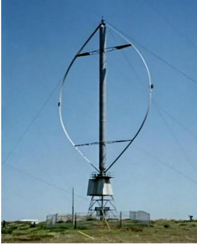
شكل (6-11) عنفة داربوس ذات المحور الشاقولي استطاعة [30kw] وقطر دوران [13m] الأشكال (4-11) و (5-11) هي عنفات ريجية حديثة وحيدة وثلاثية الاجنحة. أما الشكل (6-11) فيمثل نموذجاً خاصاً ذا محور شاقولي وهو نوع قليل الانتشار.
